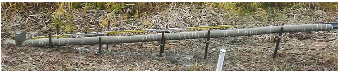
注入後のシームレスパイレンパッカー
