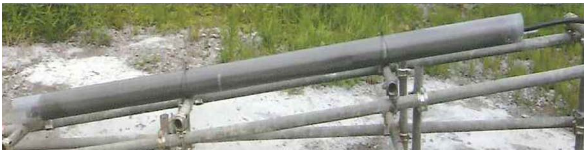
注入後のロックボルトパッカー
