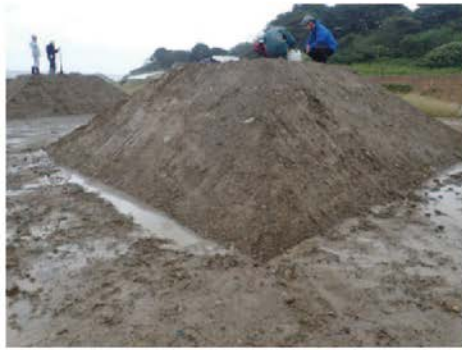
DWファイバーの混合量を変えた試験盛土
