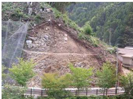
▲佐賀県の岩質斜面（施工直後）
