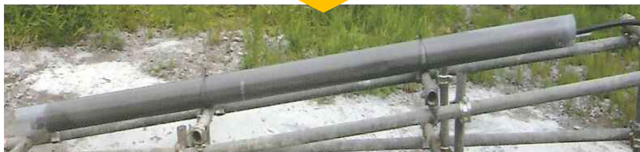
注入後のロックボルトパッカー
