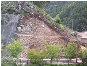
佐賀県の岩質斜面（施工直後）
