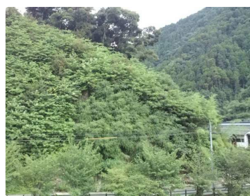
施工3年10カ月経過
